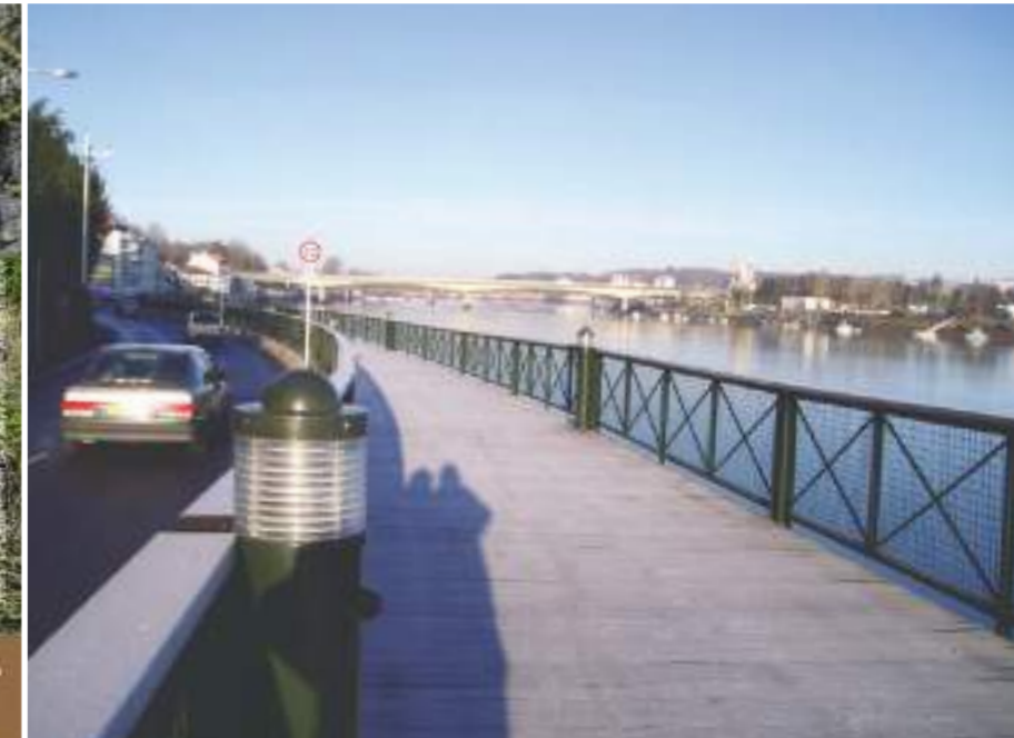
Passerelle pour piétons et vélos, en encorbellement sur le quai de l'Adour à Bayonne, Pyrénées-Atlantiques.
