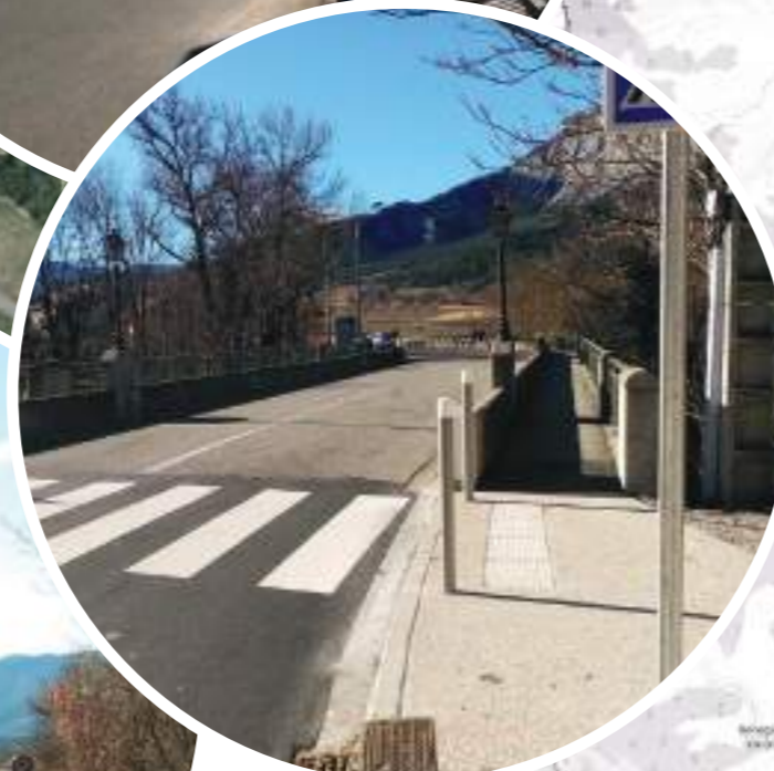
Pont de Quart : comment traiter la jonction de la vélodrome, entre la route d'Ausson, et la route de Châtillon en Diois.
