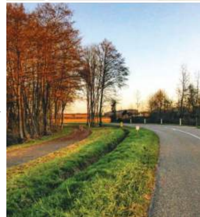
Exemple de piste cyclable en site propre, contiguë à une chaussée mais protégée par un bon séparateur (Carspach, 68).
